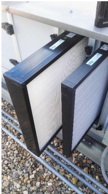
FILTROS AFP-95 MINI y AFP-50 MINI INSTALADOS
