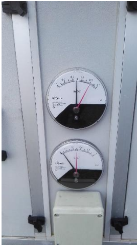
Presion AFP-95 MINI 0.48" wg Presion AFP-50 MINI 0.06" wg
